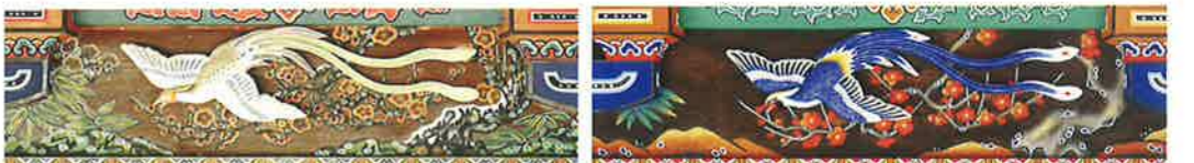
本殿背面西側 枇杷板彫刻 山鶴 (板絵: 梅・笹・土坡) (左: 修理前/右: 修理後)
