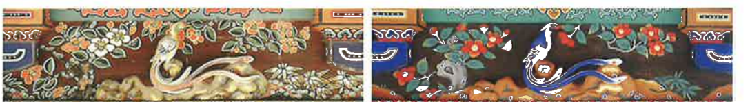
本殿背面東側 枇杷板彫刻 山鶴・土坡 (板絵: 椿・笹・土坡) (左: 修理前/右: 修理後)
