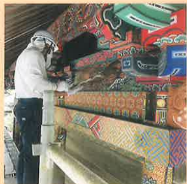
御本殿彫刻取外し状況
