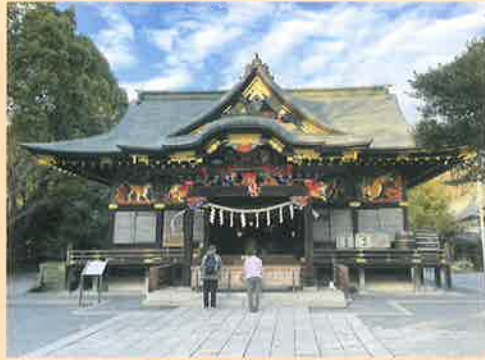
拝殿正面足場解体後状況
