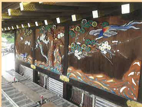
拝殿東面仕上り状況
