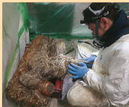
太公望既存塗膜撤去作業
