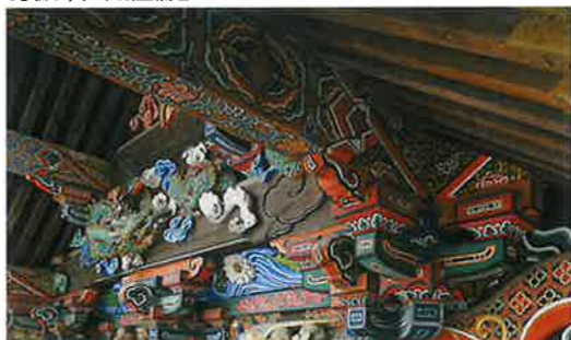
本殿妻 (修理前)
